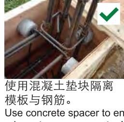
使用混凝土垫块隔离模板与钢筋。
