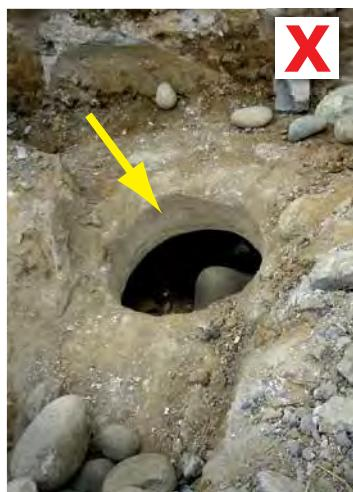
旧址重建时,若挖出旧基础,松土,大树根,井或沼气池等应妥善处理,否则会引起新的地基沉降。应该先把它们清理掉,再用小颗粒细石混凝土回填。
