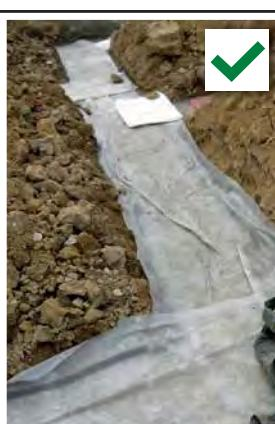
浇筑毛石基础混凝土后要做7天左右的养护。用胶布覆盖并每天浇水。
