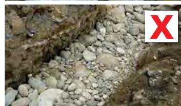
毛石不应太大或太小,平均直径应为15cm最好。毛石表面要干净,不应有泥沙。泥沙会破坏基础。
