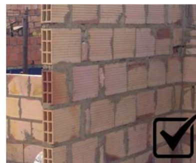
Muro de Mampostería Bloques Cerámicos, Perforación Horizontal
