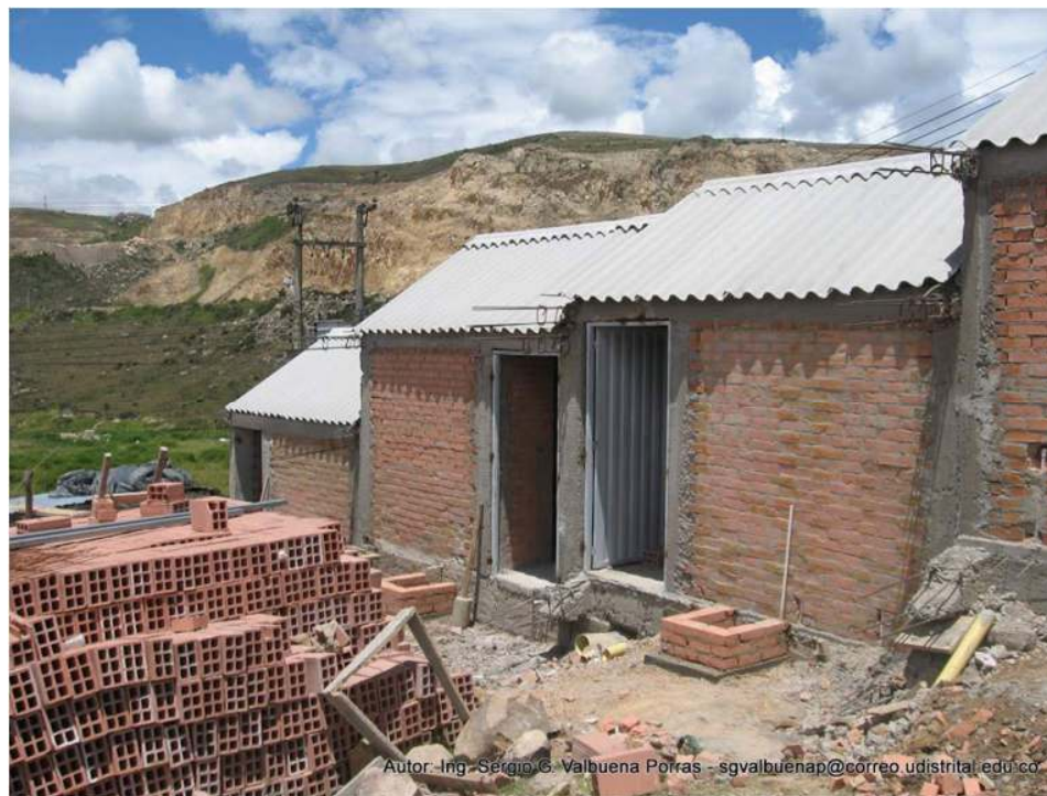
Mampostería No Reforzada (MNR) a la izquierda y Mampostería Confinada (MC) a la derecha.
