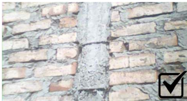
Muro de Mampostería Ladrillo
