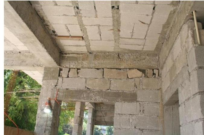
Hilada superior de mampostería sin contacto con la losa o viga superior.
